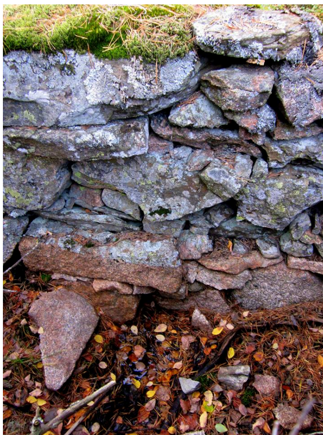
AKDG :3 Telegrafberget 2. Kallmurad väggkonstruktion i den södra stenkonstruktionens södra vägg. Väggens nedre del blottats av rotvältn. Från söder. Foto Jan Fast.
