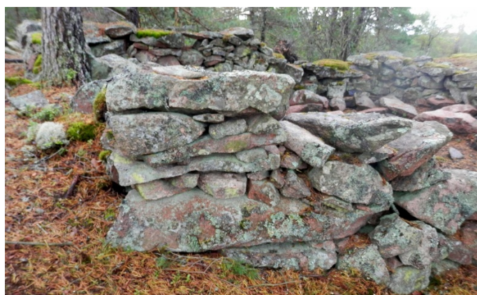
AKDG :8 Konstruktionsdetalj. Välbevarad kallmurad murkonstruktion i det nordöstra hörnet av den södra stensättningen. Foto Jan Fast.
